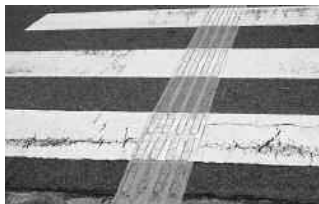
点字ブロックは歩道だけでなく、横断歩道内にもあるよ。目の不自由な人も安心して渡ることができるね。
