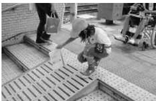
駅の階段にあるスロープはすごく急になっているから、車いすでの上り下りは無理だね。
